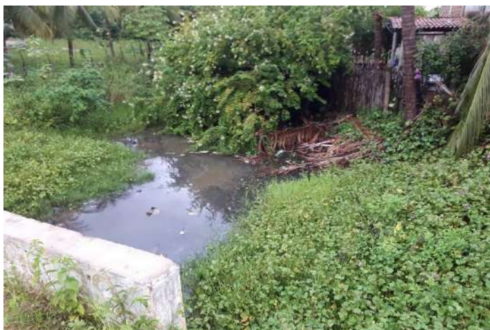
Figura 3-42 Esgoto presente no córrego em Caraúbas
