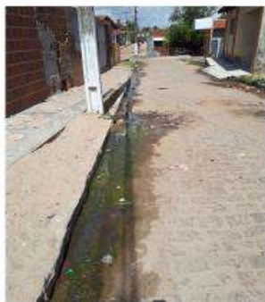
a) Esgoto a Céu aberto, rua Simão Cardoso
