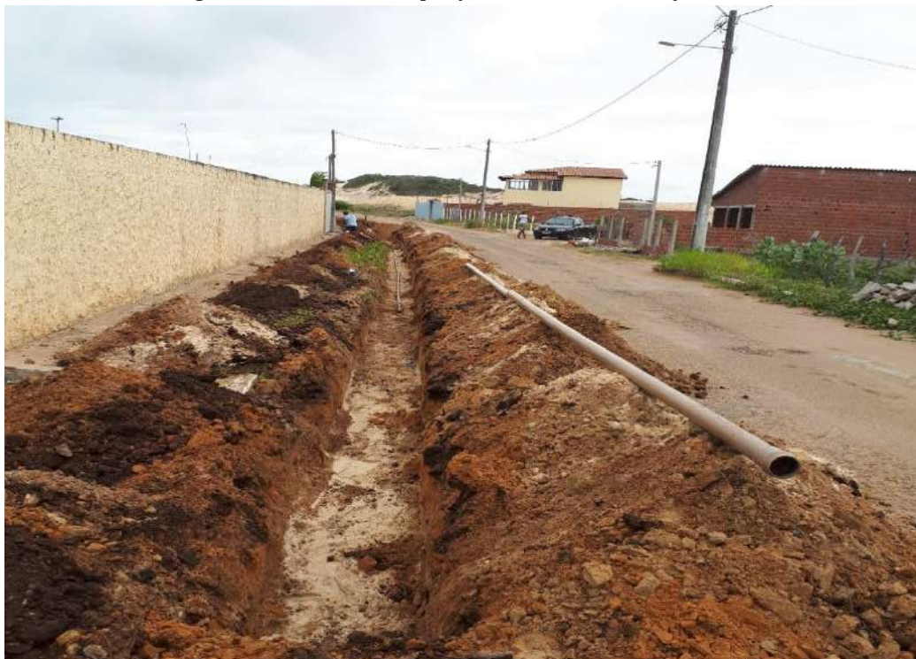
Figura 3-10 - Obra de ampliação de rede em Maracaju
