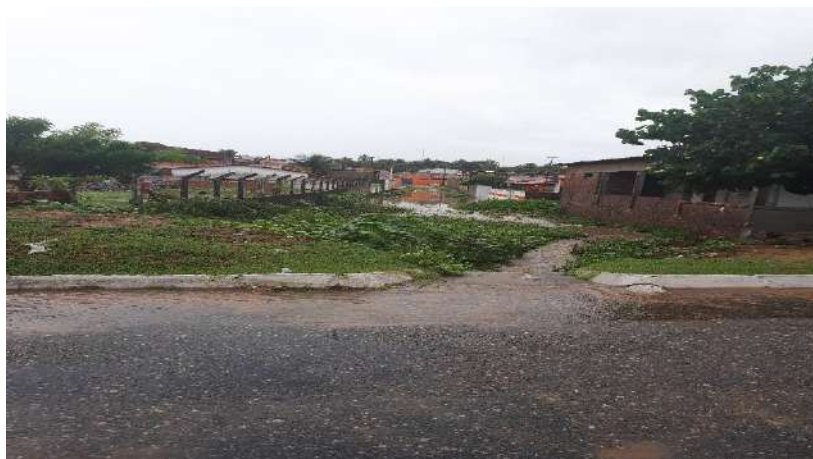
Figura 3-62 Zona de Alagamento na rua Fernando Cisneiro
