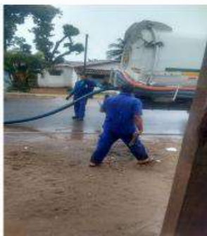
b) Limpeza de fossa, UBS.
