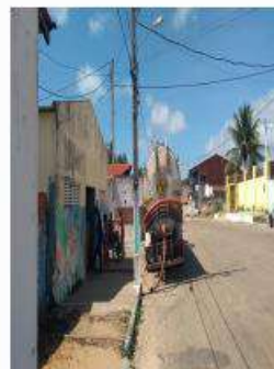
c) Limpeza de fossas no mercado público em Maracajá.
