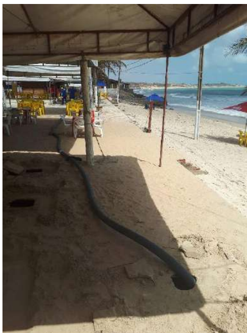
Figura 3-40 Limpeza de fossas nos quiosques da praia.
