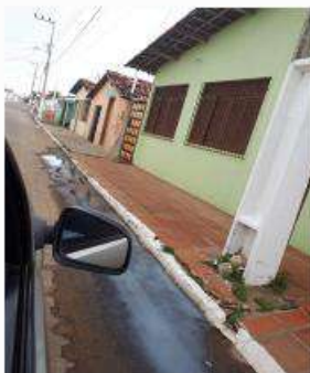
b) Esgotos a céu aberto.
