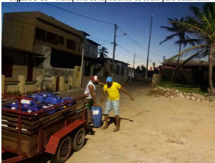
Figura 3-32 - Transporte de hipoclorito de sódio para tratamento
