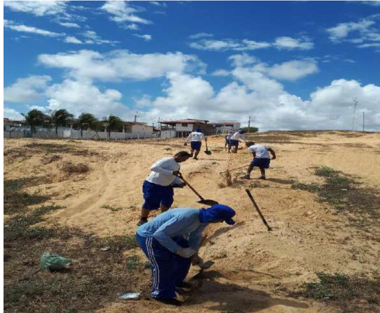
Figura 3-5 - Obra de ampliação de rede de Maxaranguape
