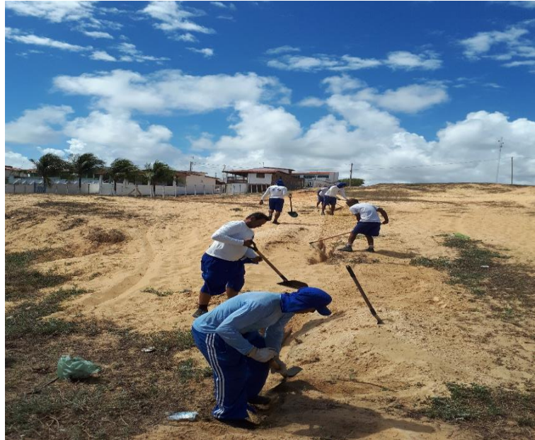
Figura 3-5 - Obra de ampliação de rede de Maxaranguape
