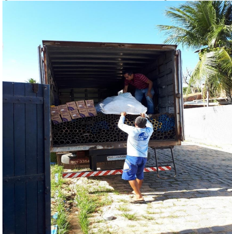
Figura 3-4 - Recebimento de material hidráulico e despesas do SAAE – 2017
