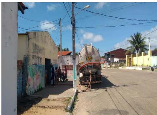
Figura 3-39 Limpeza de fossas no mercado público em Maracajá.
