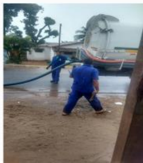
b) Limpeza de fossa, UBS.
