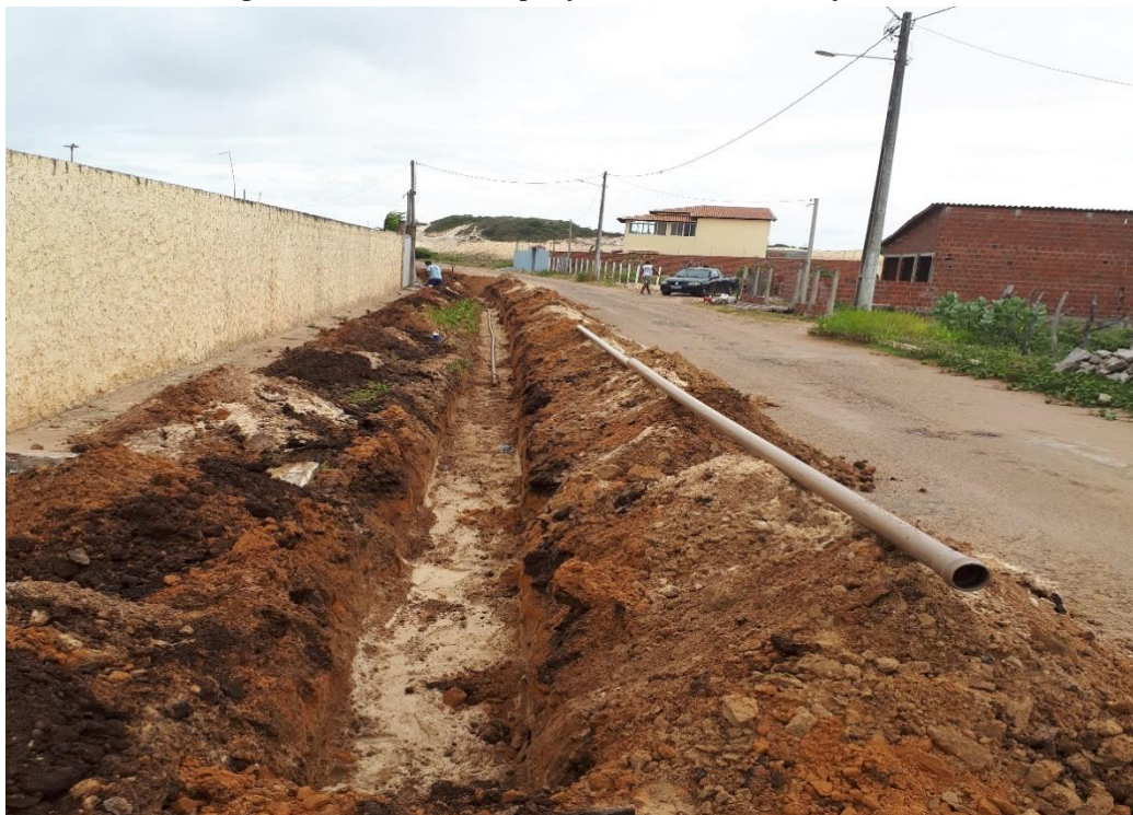
Figura 3-10 - Obra de ampliação de rede em Maracaju
