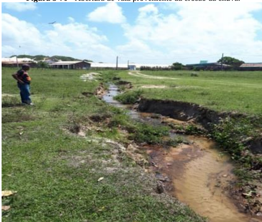
Figura 3-70 - Abertura de vala proveniente da erosão da chuva.
